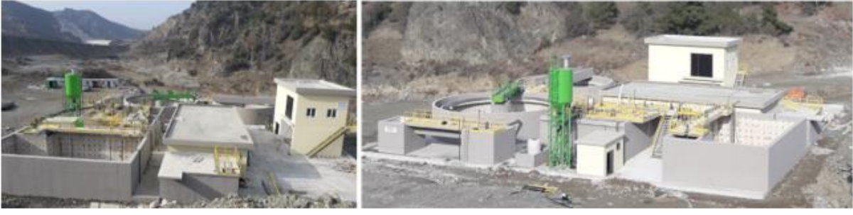
Şekil 3: Atık Su Arıtma Tesisi ve Çökeltme Havuzu
