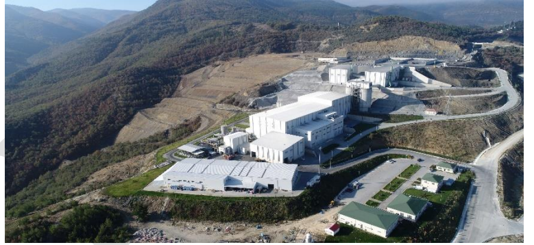
Şekil 6: Flotasyon Tesisi ve Yardımcı Üniteler
